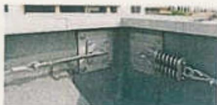
*Piastra a cerniera particolarmente adatta al montaggio di pali su qualsiasi tipo di tetto (una falda, due falde simmetriche o asimmetriche ecc.). La sua particolare conformazione garantisce perfetta adattabilità alle eventuali sconnessioni del tetto.*
