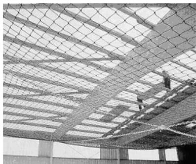
Fig. 9.2.3-3 Esempio di utilizzo di un sistema S (coperture di grandi capannoni industriali)
