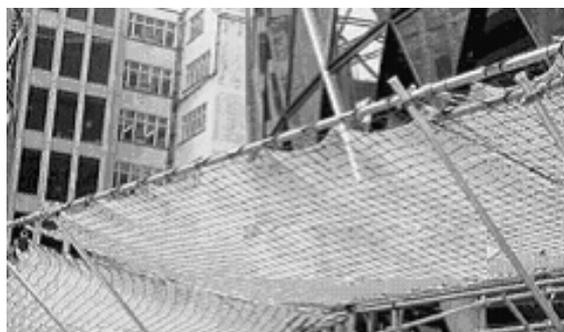
Fig. 9.2.4-2 Esempio di utilizzo di un sistema T (costruzione di edifici)
