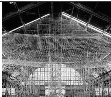
Fig. 9.2.3-2 Esempio di utilizzo di un sistema S (coperture di grandi capannoni industriali)
